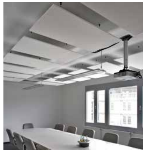
Deckensegel für ein Besprechungszimmer um eine hohe Sprachverständlichkeit zu erzielen.
