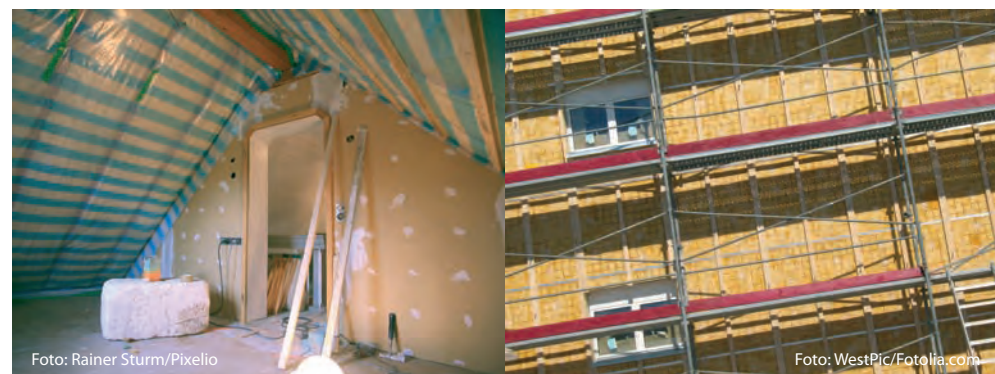
Nachdem Dämmmaterial, zum Beispiel Mineralwolle, zwischen die Dachsparreneingefügt ist, ist eine Folie als Dampfsperre nötig, bevor Gipskartonplatten und der Wandbelag folgen.
